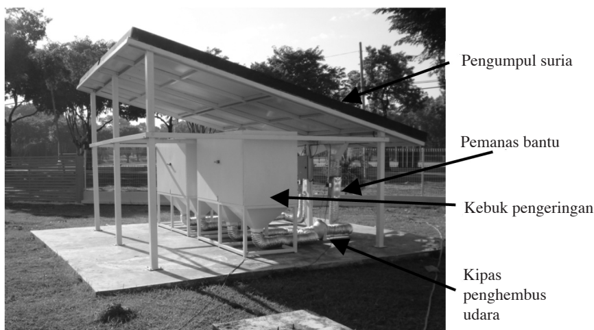
RAJAH 1. Gambar sistem pengeringan suria untuk rumpai laut
